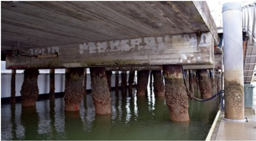
شکل ۲- خوردگی پایه های پل در بخش هایی که تحت جذر و مد هستند.
